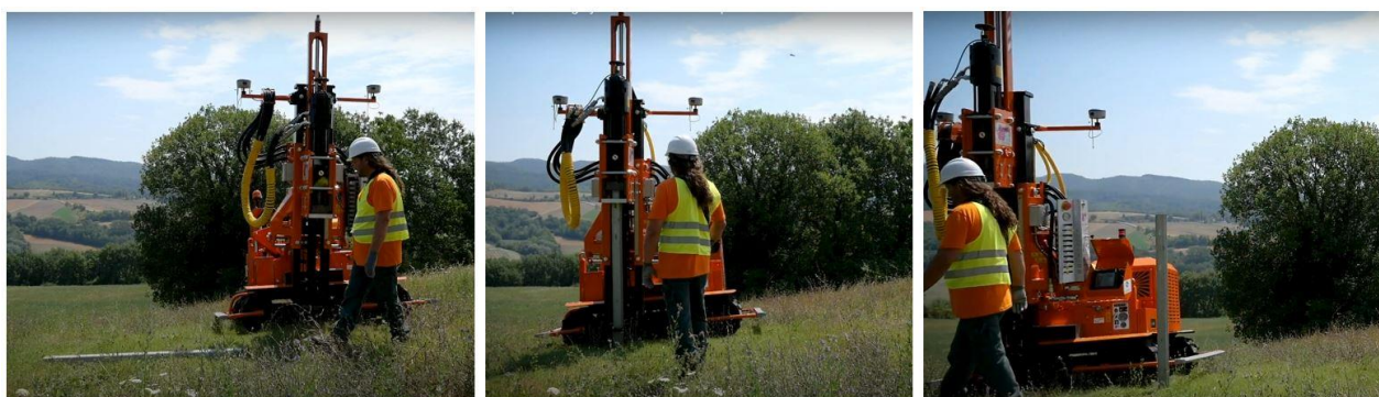
Slika 2.6 Postavljanje stupova s mehanizacijom (Izvor: Idejno rješenje)
