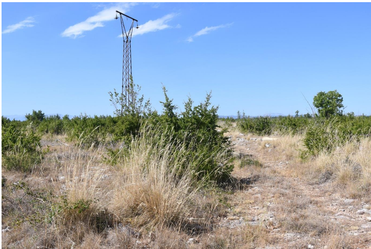
Slika 3.3 Dalekovod 35 kV unutar područja planiranog zahvata (Izvor: terenski obilazak)
