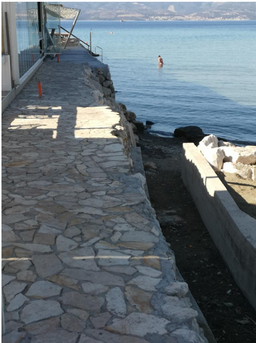
Slika 1.1-2 Oborinski kanal sa desne strane lukobrana (Zeleni servis d.o.o., 28.07.2020.)
