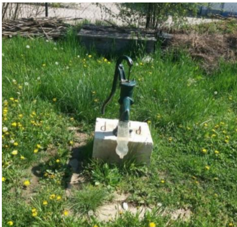
Fotografija 3-3: Zdenac Z3 s ugrađenom ručnom pumpom
