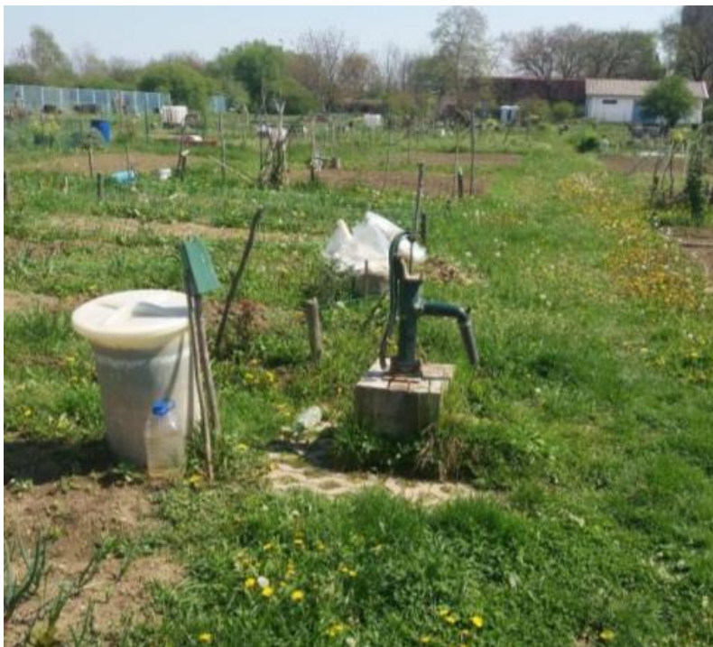
Fotografija 3-2: Zdenac Z2 s ugrađenom ručnom pumpom
