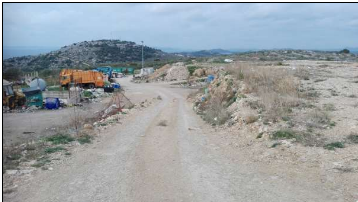
Slika 2.1.-2. Pogled s tijela na ulazni i pristupni dio odlagališta
