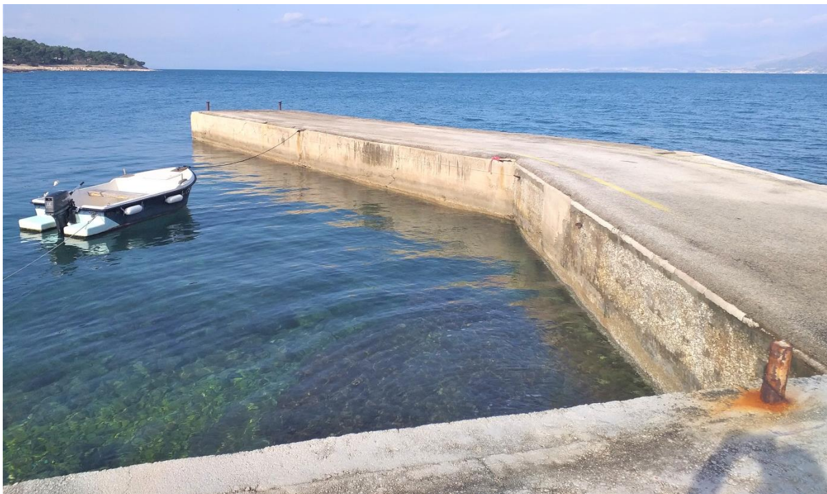
Slika 1.1-2 Postojeći betonski pristanišni gat (Zeleni servis d.o.o., veljača 2020.)
