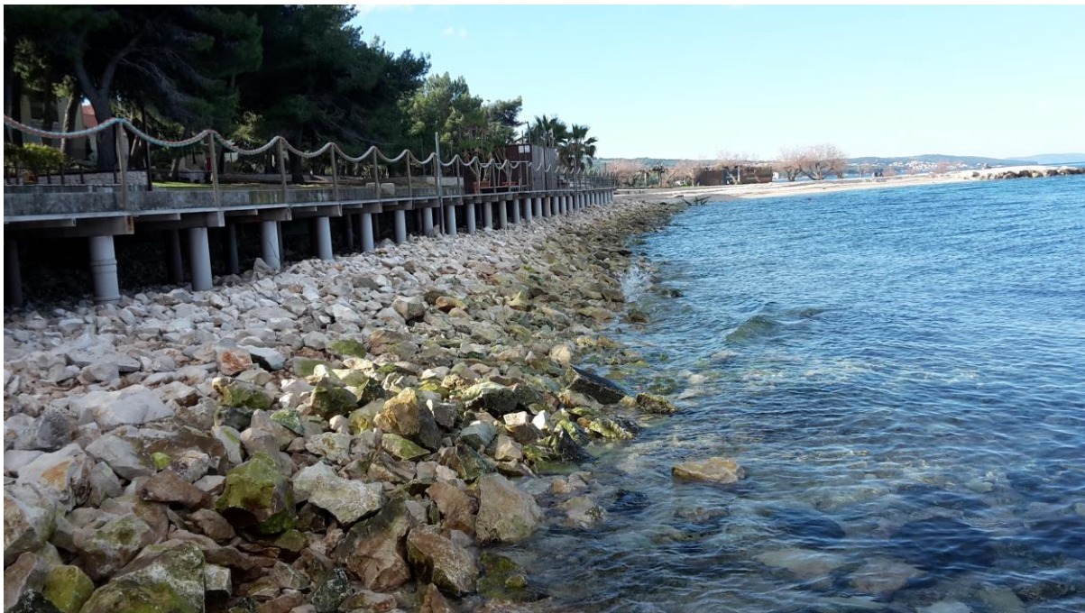
Slika 1.1.-4: Izgled nasipa na lokaciji „Tri mosta“ duljine cca.100 m (pogled sa istoka prema drvenom pontonu)
