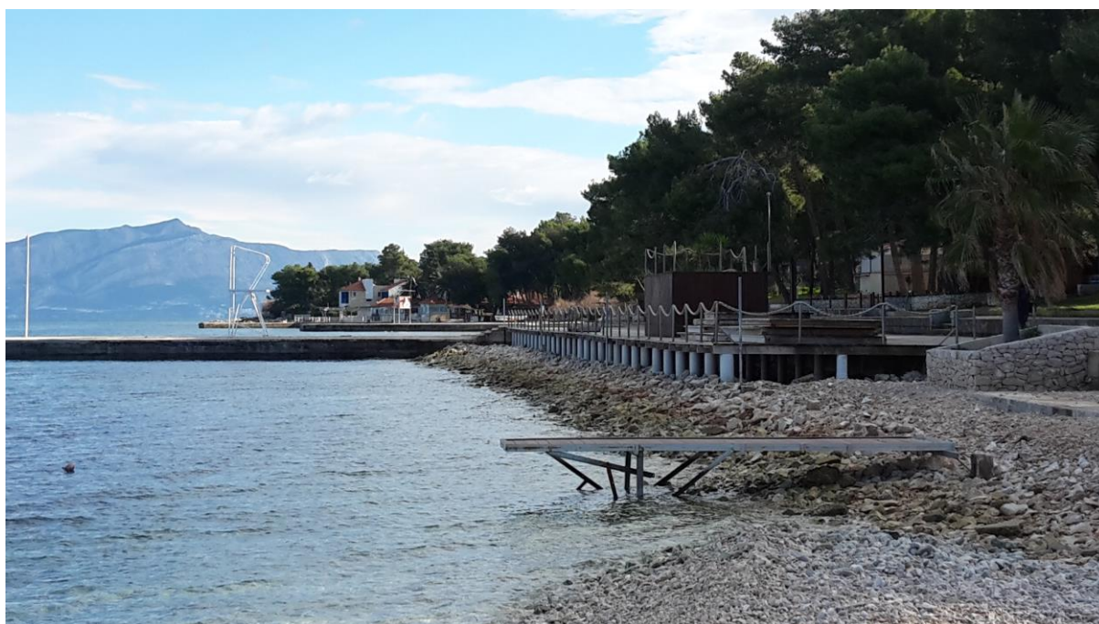
Slika 1.1.-5: Izgled nasipa na lokaciji „Tri mosta“ duljine cca.100 m, pogled sa zapada
