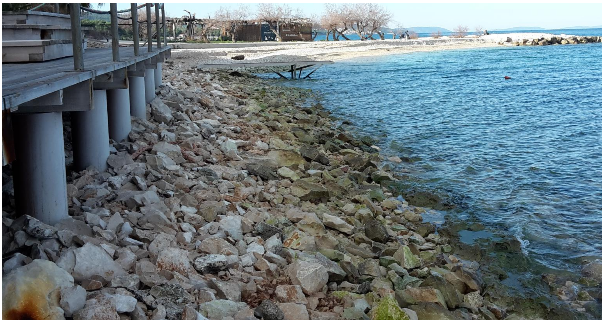
1.1.-6: Izgled nasipa na lokaciji „Tri mosta“ na kojem je vidljivo je da je materijal cijelom dužinom nasut u more
