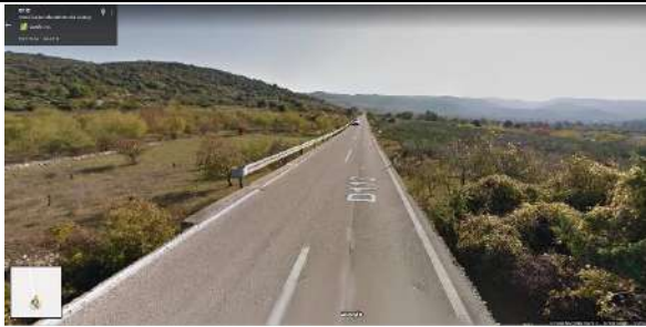
Točka 5. Bankina uz lijevu stranu ceste i oštećenje ceste (kolotrazi)
