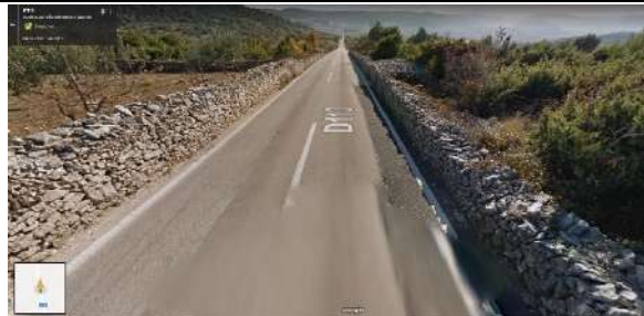
Točka 4. Izgrađen suhozid s obje strane ceste
