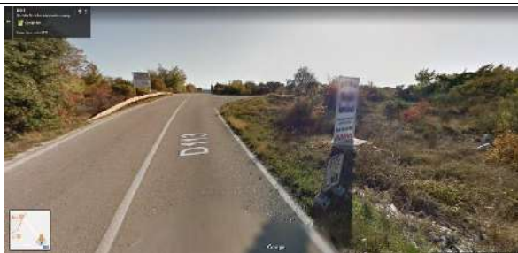
Točka 1. Početna dio rekonstrukcije ceste s T križanjem s odvojkom za Donji Humac (LC67172); zaštitna odbojna ograda
