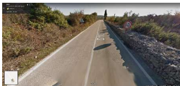
Točka 2. Izgrađen suhozid uz desnu stranu ceste
