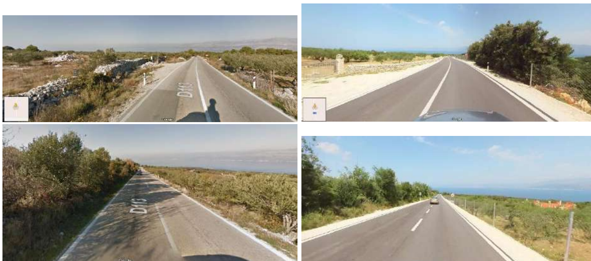
Slika 4. Primjeri rješenja ograđivanja međa sa žičanom ogradom na obnovljenom dijelu ceste DC113 prema Supetru (lijevo: prije rekonstrukcije, desno: poslije rekonstrukcije) (izvor: www.google.hr/maps -Street View, pristupljeno: 24.9.18)
