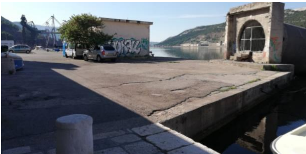
Slika 4. Pogled na predmetni zahvat sa zapadne strane
