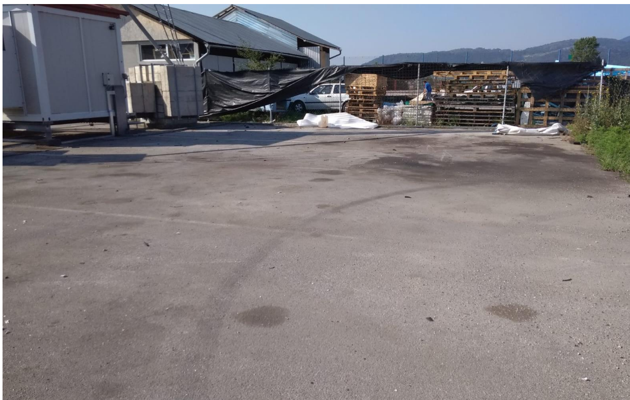
Slika 1./2. Postojeće stanje – izbetonirana površina istočnog dijela parcele predmetnog zahvata
