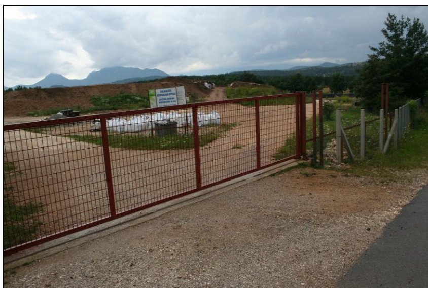
Slika 4. Odlagalište Čojluk - stanje izvedenih radova (pogled na ulazno-izlaznu zonu)
