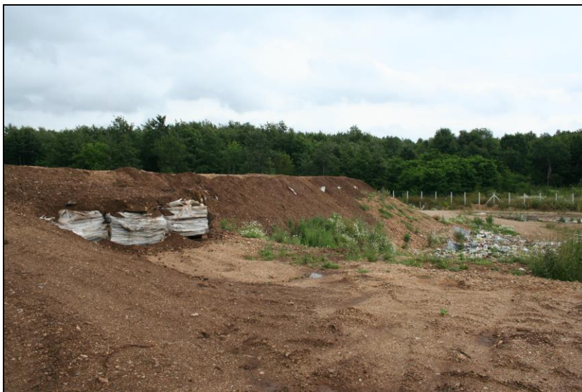
Slika 5. Odlagalište Čojluk - stanje izvedenih radova (pogled na Plohu 1-azbestni otpad)
