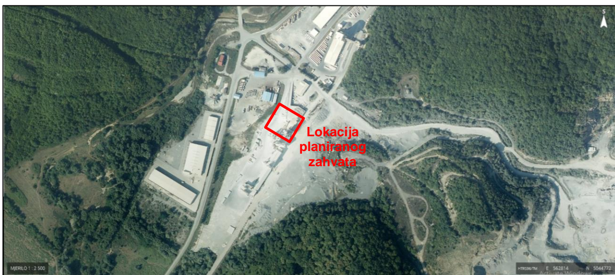
Sl. 3.2-2: Lokacija planiranog zahvata unutar Tvornice vapna 2
