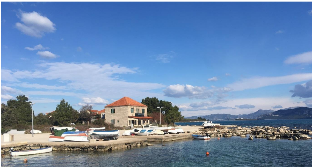
Slika 1.1-4: Betonska rampa za spuštanje plovila (Zeleni servis d.o.o., veljača 2019.)
