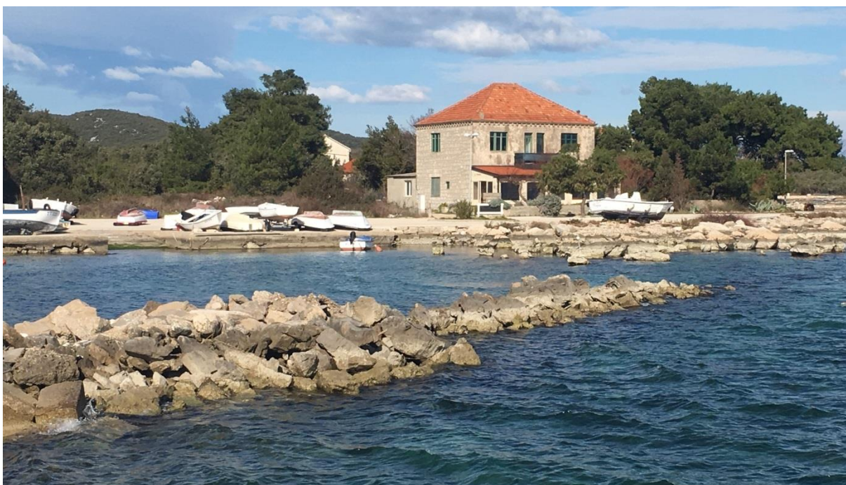
Slika 1.1.-5: Kameni nasip sa vanjske strane postojećeg lukobrana (Zeleni servis d.o.o., veljača 2019.)
