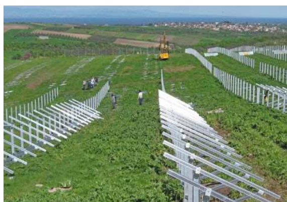
Slika 2: Detalj montaže na zemljanoj površini
