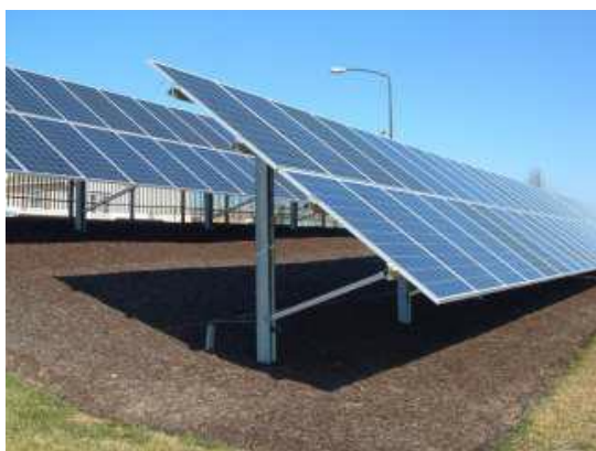
Slika 2: Detalj montaže na zemljanoj površini
