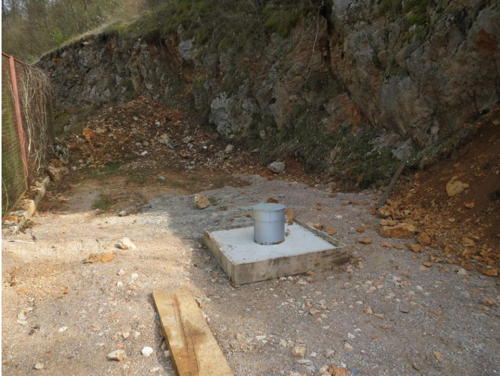
Slika 9. Lokacija buduće crpne stanice
