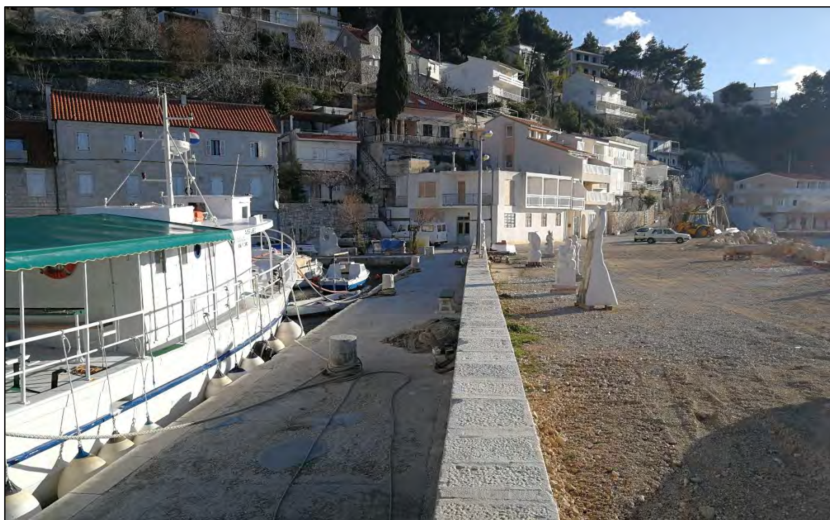
Slika 8. Lokacija zahvata, pogled s lukobrana prema istoku
