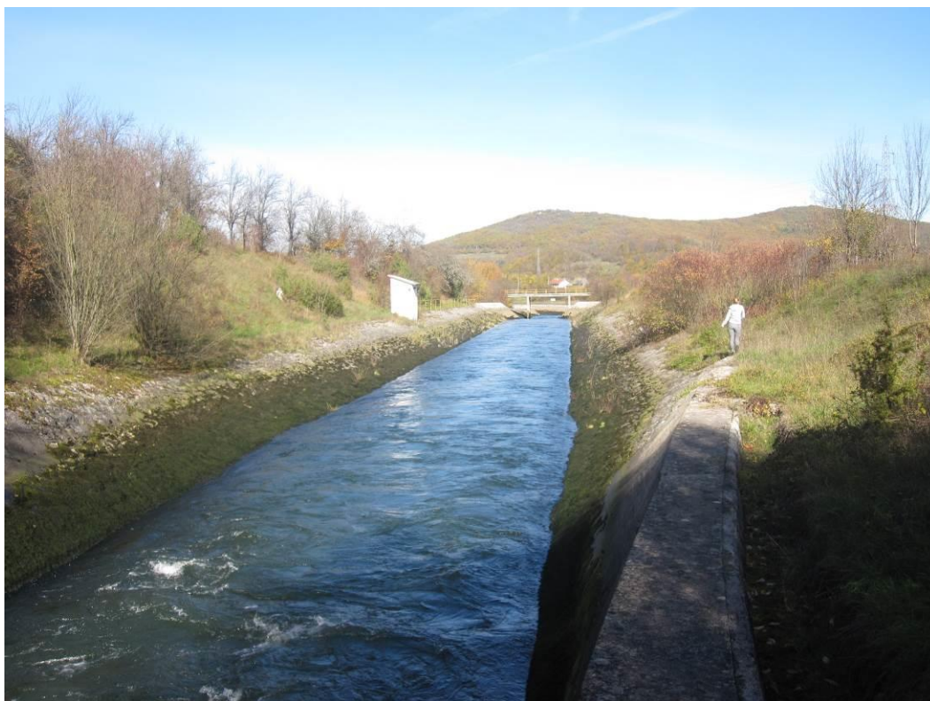
Slika 10.2.10: Uzvodni dio Kanala Like s vodomjernom postajom – desno će se izvesti dovodni kanal za MHE Otočac
