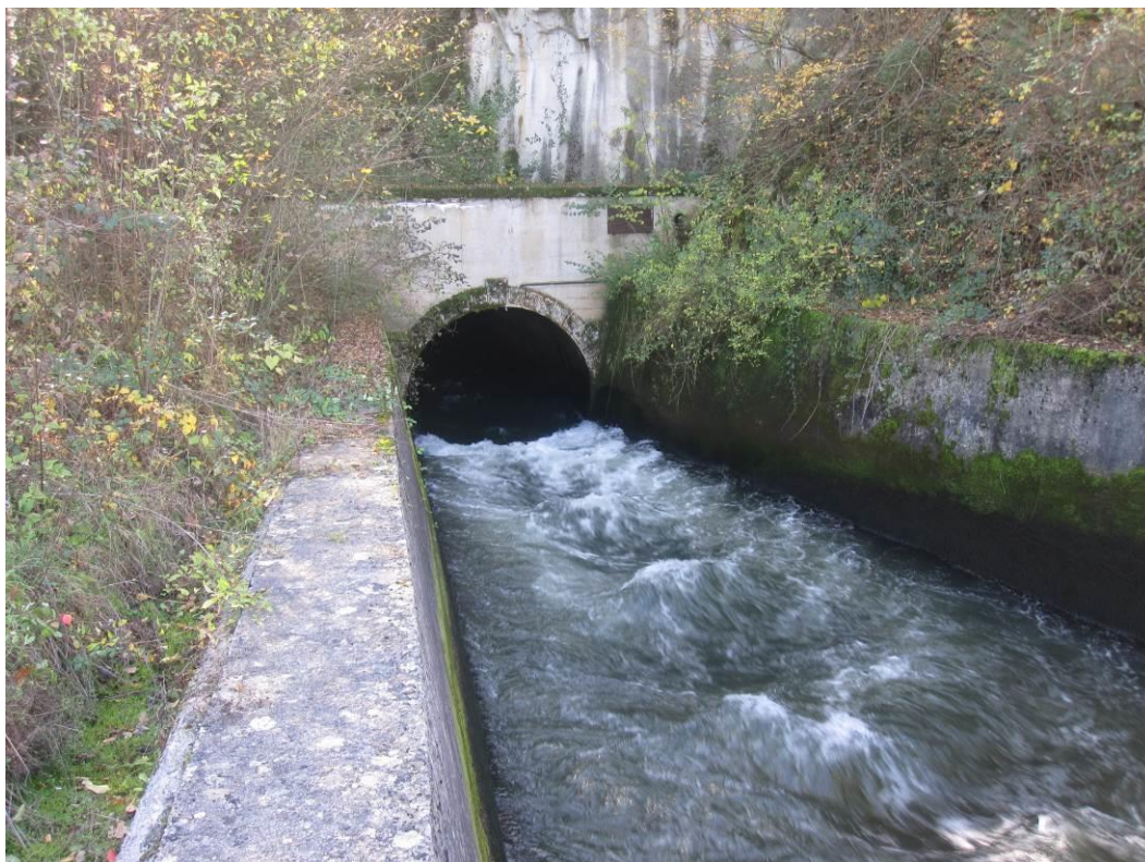
Slika 10.2.9: Izlaz tunela Lika - Gacka
