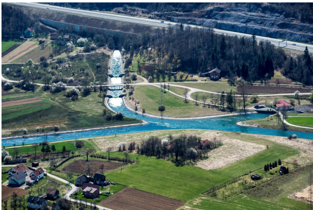
Slika 1.4.1 Odvodni kanal Lika i čvorište Šumečica - postojeće stanje
