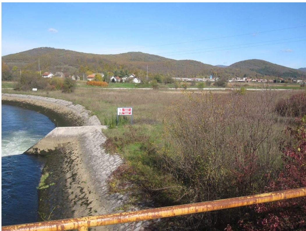
Slika 10.2.8: Nizvodni dio lokacije planirane MHE Otočac – zona odvodnog kanala
