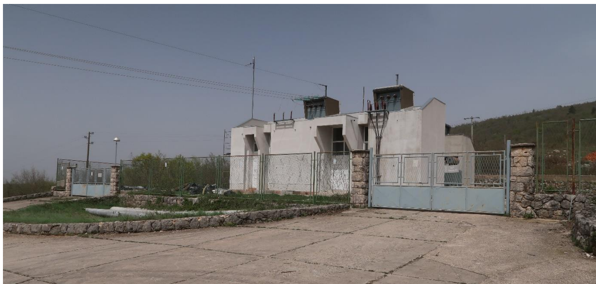
Slika 3.11./14. Trafostanica u okolini zahvata, sjeverno na križanju DC60 i ŽC6179
