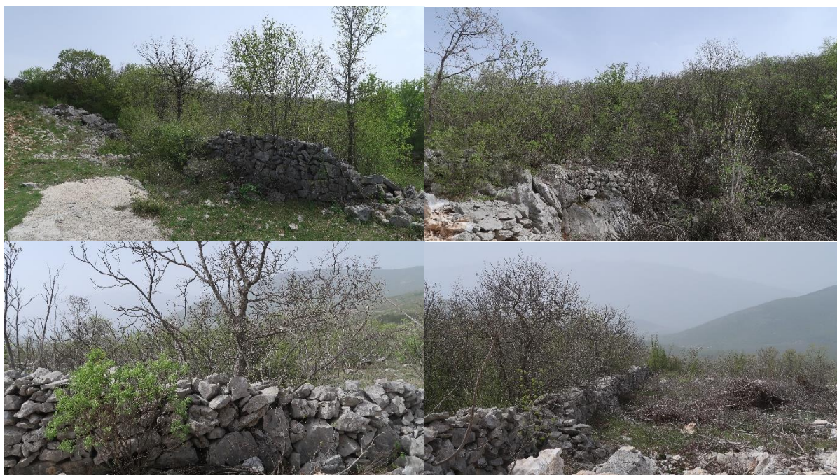
Slika 3.11./10. Suhozidne konstrukcije u zoni zahvata (dijelom oštećene konstrukcije)
