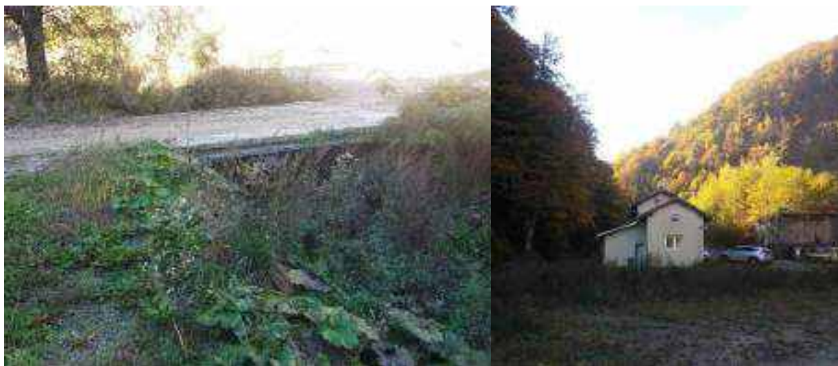
Slika 1.1./6. Most preko potoka unutar zahvata i objekt
