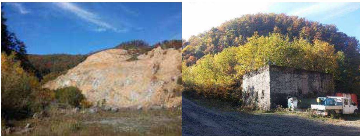
Slika 1.1./4. Postojeće stanje i staro postrojenje
