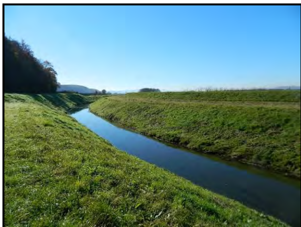
Slika 3.10-8. Pogled na lokaciju mosta preko rijeke Londže (autor: Matea Lončar, studeni 2015., S.7)
