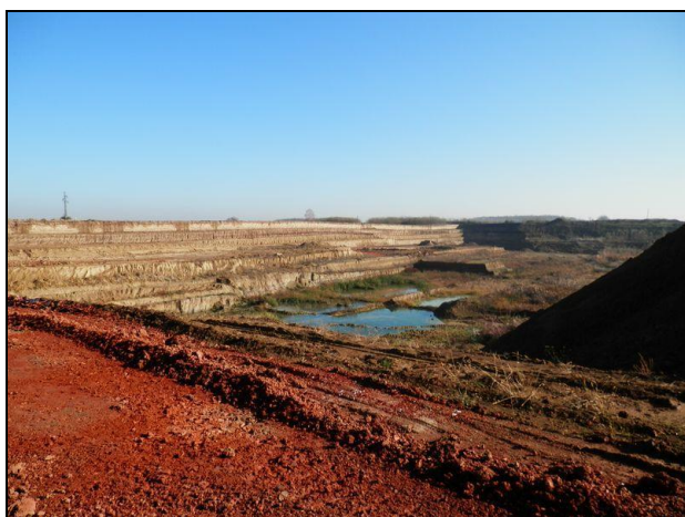
Slika 3.10.2.6. Radovi na PK "Slavonka"
