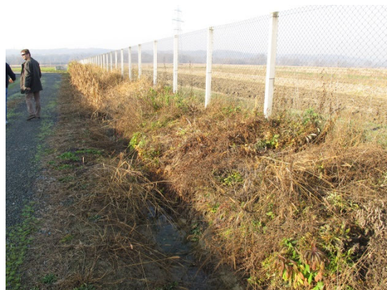
Slika 15. Kanal na lokaciji zahvata
