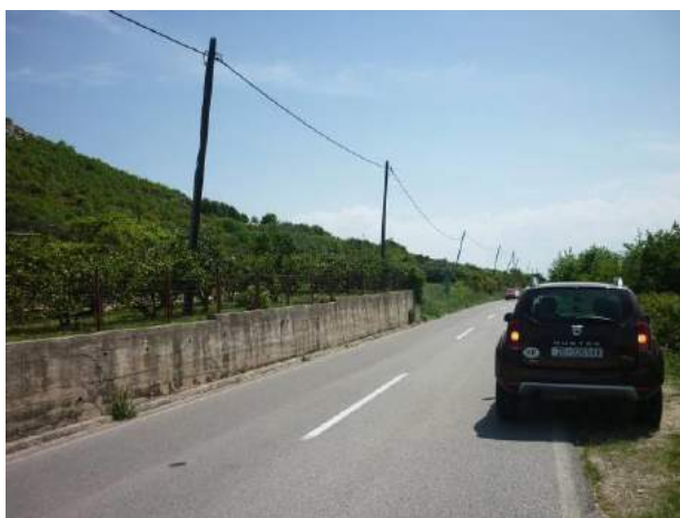
Slika 3.10./13. Županijska ceste Ž6091 u zaselku Maljkovići
