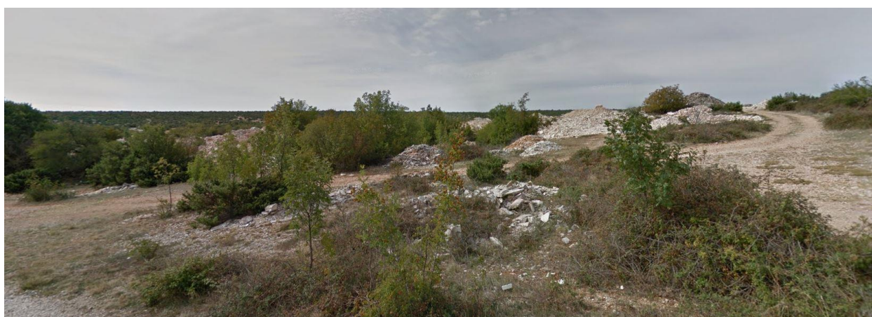
Slika 4.1./7. Pogled (3) s lokalne ceste L63131 prema EP "Sv. Ante-Zadar"
