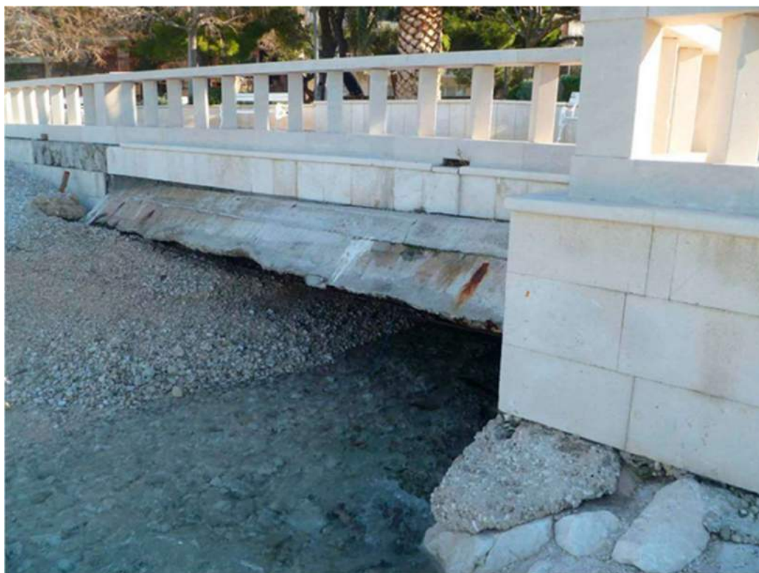
Slika 2.1-6. Završetak bujice „Suhi potok“ u zidu šetnice.
