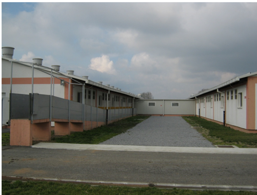
Slika 2. Komunikacijski hodnik i rampa
