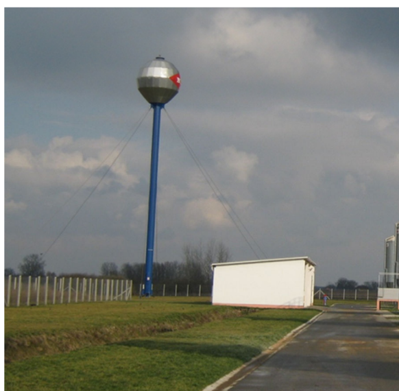
Slika 8. Vodotoranj i nadstrešnica sa spremištem
