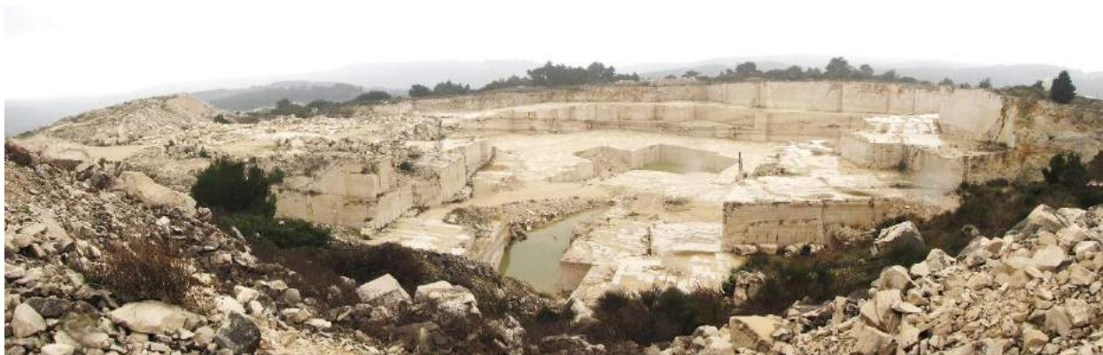
Slika 3.8./3. Postojeći površinski kop "Glave" istočno od EP
