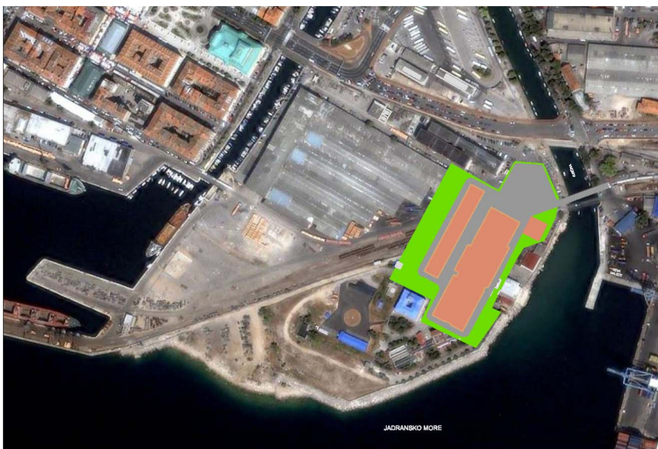
Slika 1.2.3.1: Lokacija uređaja za pročišćavanje otpadnih voda sustava javne odvodnje „Grad“
