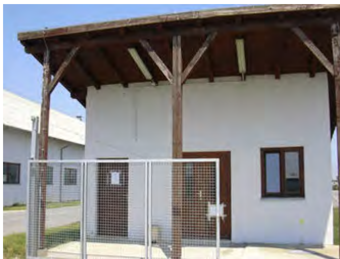
Slika 8. Čuvarska kućica sa skladištem opasnog otpada i skladištem opasnih tvari
