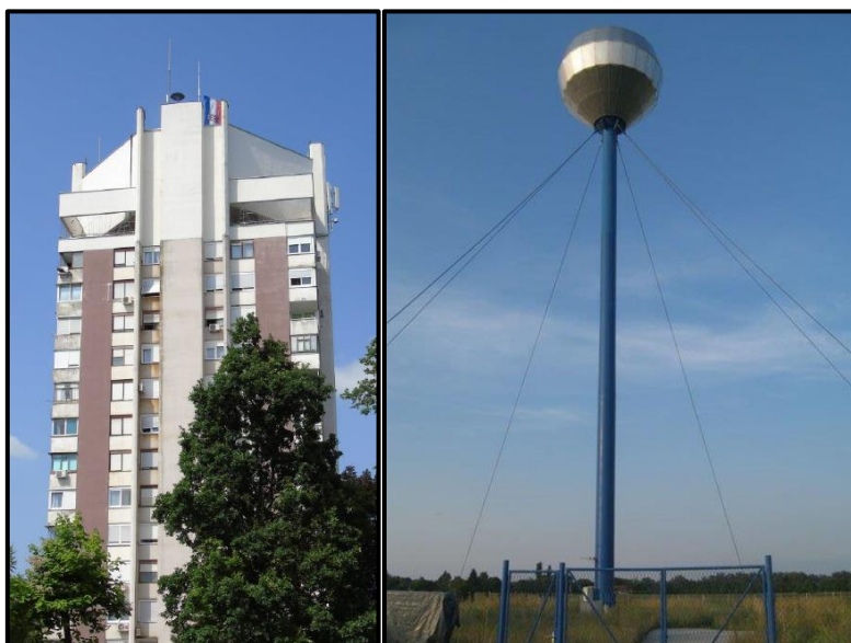
Slika 2.1-2. Vodospremnik Velika Gorica (a) i vodotoranj Veleševac (b) (preuzeto iz Hidroprojekt-ing i dr., 2017.)
