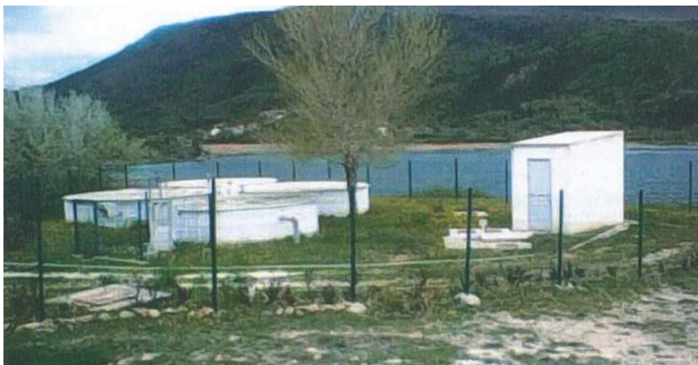
Slika 2.1.1-2. Postojeći uređaj za pročišćavanje Golubić – pogled sa zapadne strane
