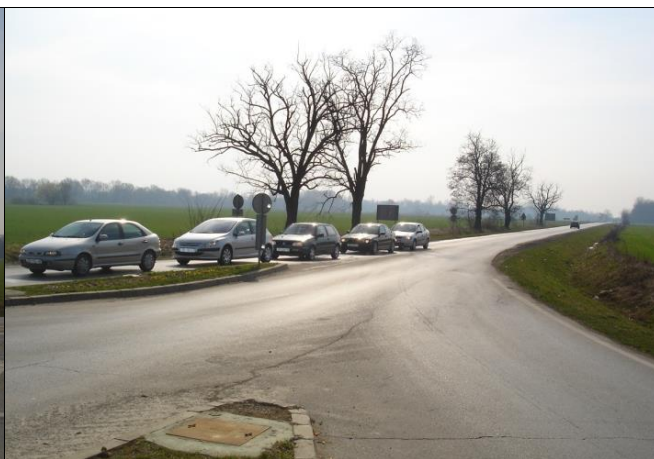
SLIKA 4 – pogled na istočni dio Industrijske zone
