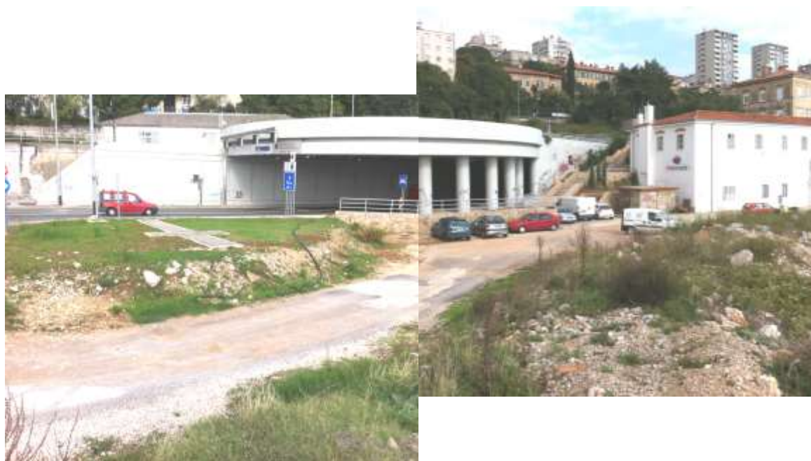
D404, portal tunela, poslovni objekt i stambene građevine
