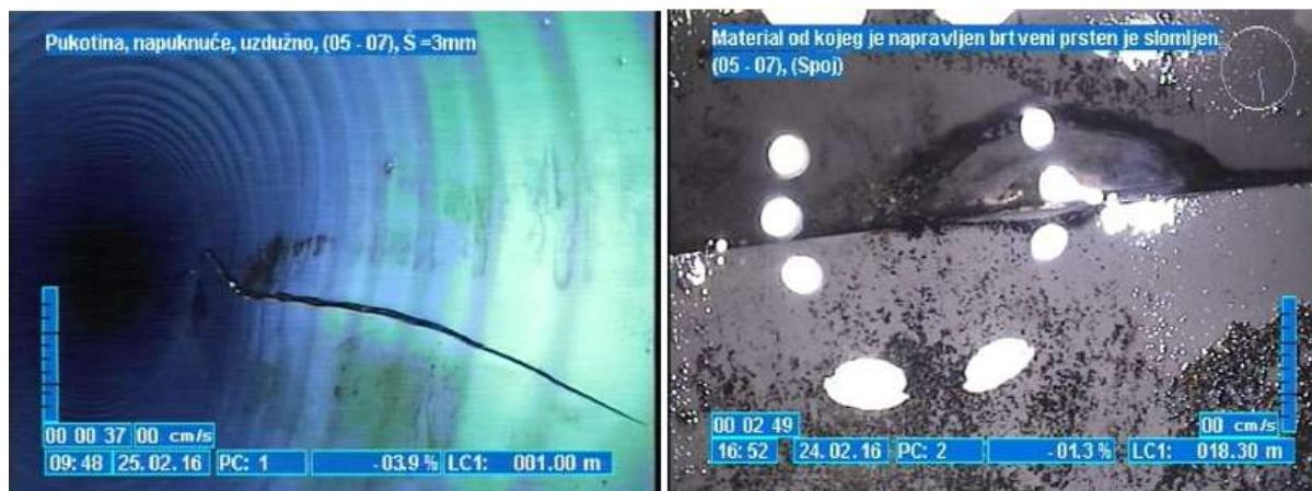
Slika 1.1-1. Snimke deformacija sa CCTV kamerom - napuknuće i oštećenja na brtvenom prstenu
