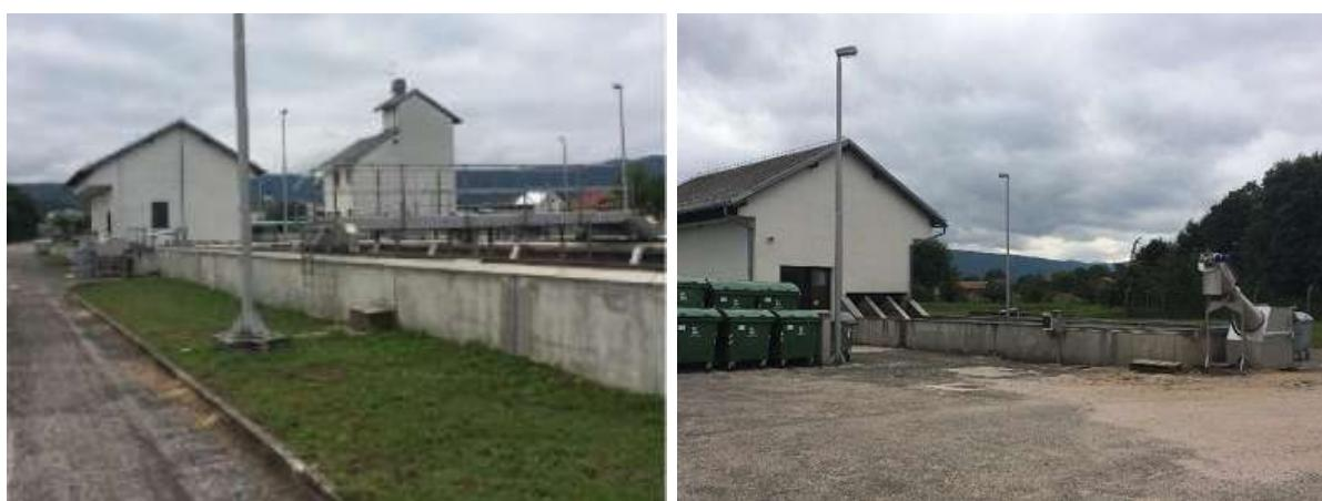
Slika 2.1.2-4. Pogled na UPOV Otočac, ulaznu građevinu i komandnu zgradu (a) i ulazna građevina s grubom rešetkom za odvajanje krupnog otpada (b)
