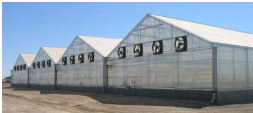
Slika br. 31 - Primjer objekta za solarno sušenje mulja
