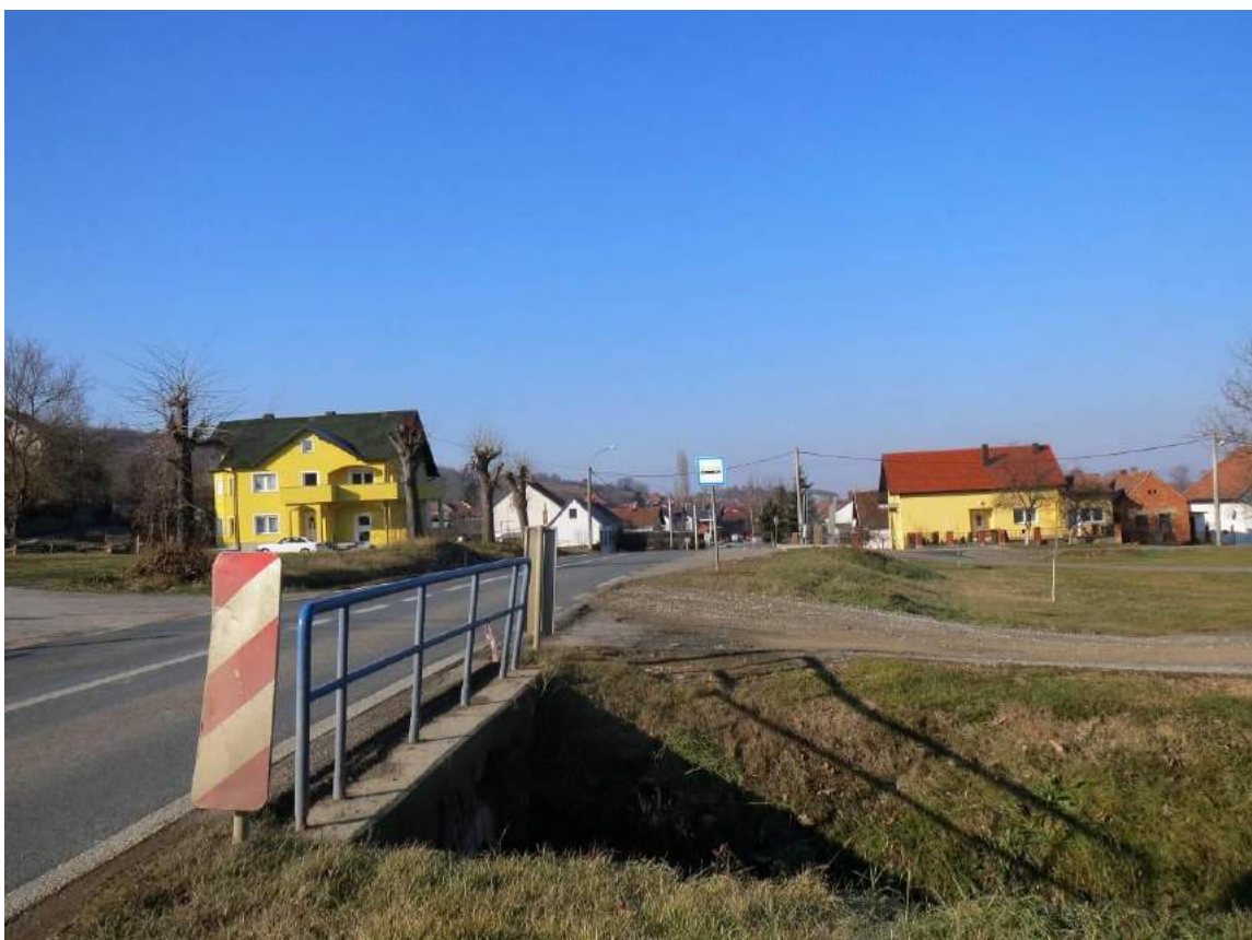
Slika 21. Vodotok sa otvorenim tipom odvodnje kojeg presijeca DC38
