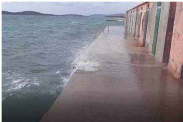
Slika 1.1.3.13. Preljevanje obalnog zida Zone B pri umjerenom jugu
