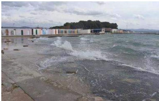
Slika 1.1.3.11. Prelijevanje obalnog zida Zone A pri umjerenom jugu
