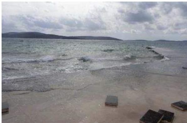
Slika 1.1.3.12. Prelijevanje obalnog zida i gata Zone A pri umjerenom jugu
