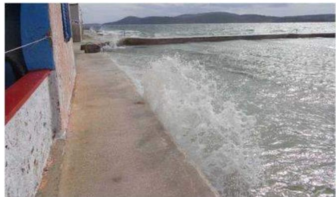
Slika 1.1.3.14. Preljevanje obalnog zida Zone C pri umjerenom jugu
