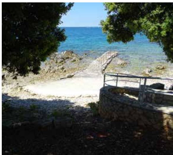
Slika 40: Rampa za ulazak u vodu
