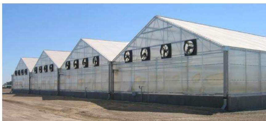
Slika br. 26 - Primjer objekta za solarno sušenje mulja
