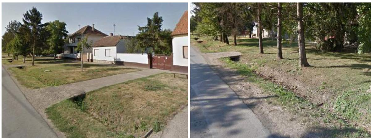
Slika 2.1-1. i 2.1-2. Način odvodnje oborinskih voda (sustav otvorenih kanala)
