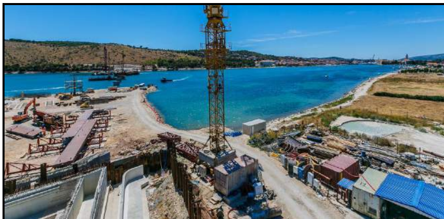
Slika 3.1.8-2. Novi most kopno-otok Čiovo: 1) vizualizacijski prikaz mosta, 2) izgradnja mosta
