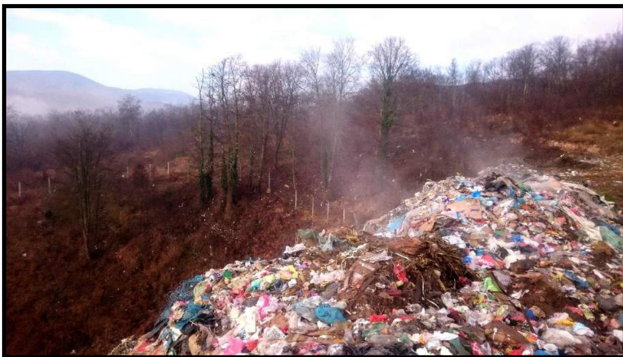
Slika 2.2.-5. Postojeće stanje lokacije odlagališta "Javorov vrh"
