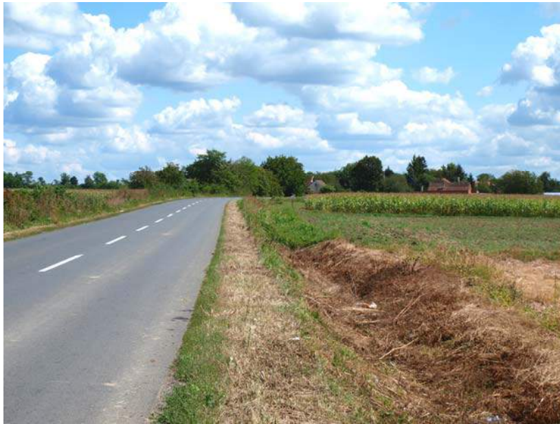
Slika 35. Lokacija budućeg čvorišta brze ceste (u pozadini selo Godinjak)
