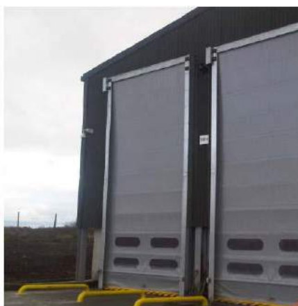
Slika 4.4/1 – Uobičajena vrata za prihvrat otpada [1]
