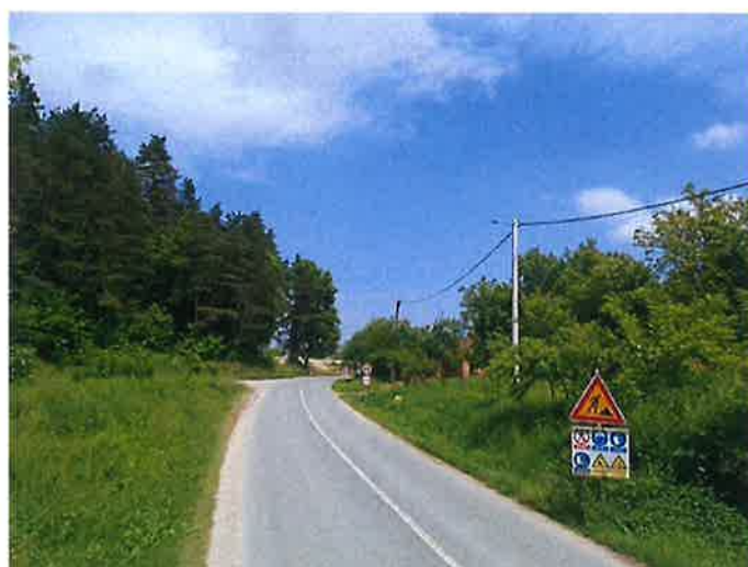
Pogled prema gradilištu buduće brze ceste sjeverno od MM1
