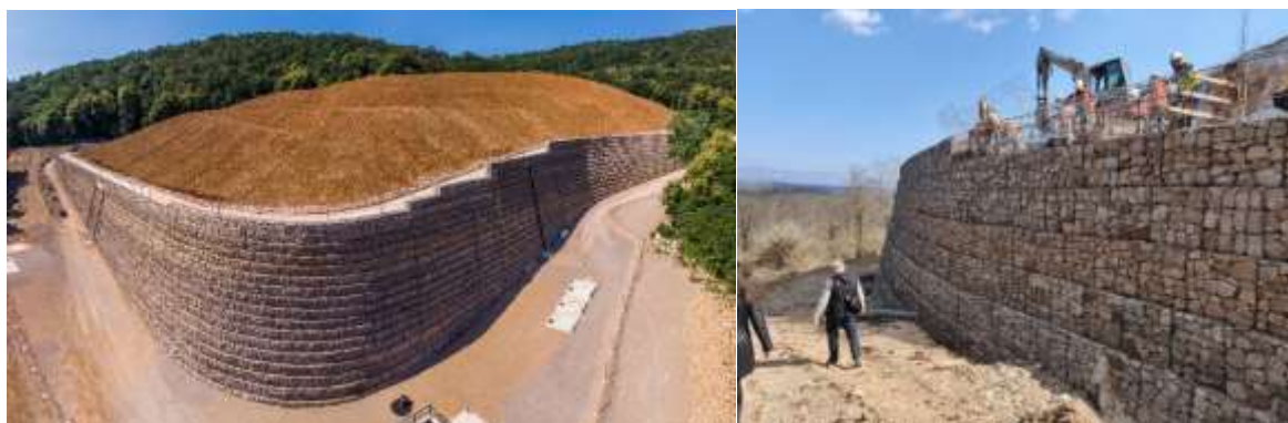
Slika 1.2.1/1 – Primjer izgradnje odlagališta oblikovanjem armiranim tlom
