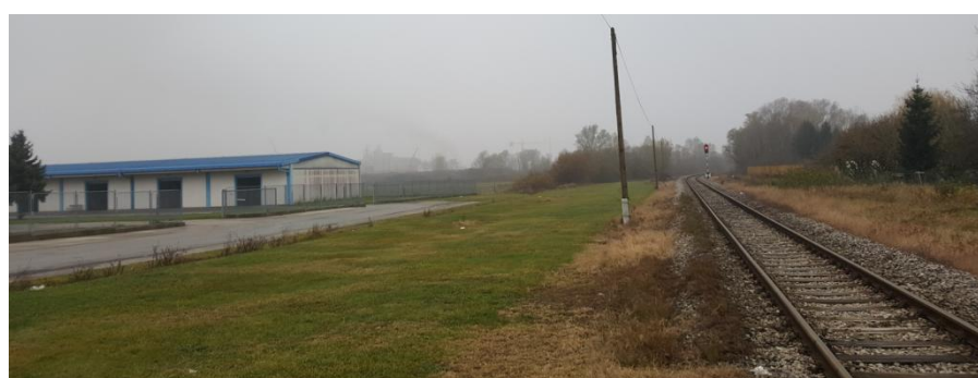
Slika 4.18. Pogled na gospodarsku proizvodnu zonu i željezničku prugu Krizevci-Bjelovar-Kloštar
