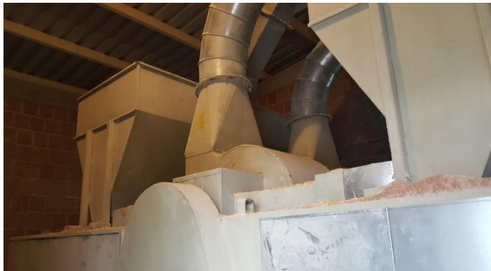
Slika 5.2. Prikaz centralnog sustava za otprašivanje na lokaciji tvornice Gašpar d.o.o.
